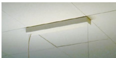
SEPARAÇÃO CC DE 60 CM ENTRE OS CABOS DO SUPORTE DE FIXAÇÃO
